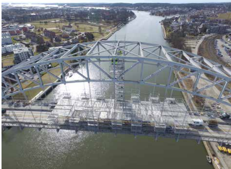
HØYT OPPE: Arbeidene på Fredrikstadbrua er flyttet til midtspennet der Consolvo-arbeiderene er i aksjon 70 meter over vannet. Foto: Consolvo AS.
