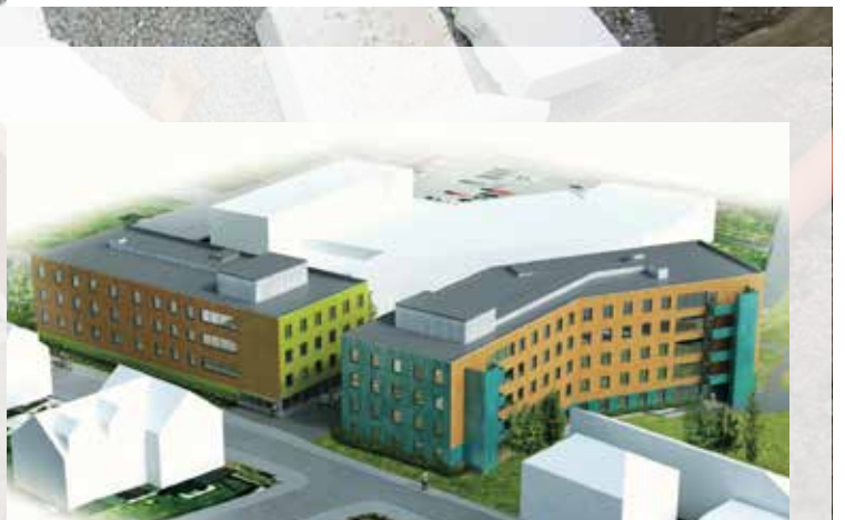
MASSIVTRE: Studentbolig-prosjektet består av to boligblokker på henholdsvis tre og fire etasjer. Hovedkonstruksjonen er i massivtre. Illustrasjon: Code arkitektur
